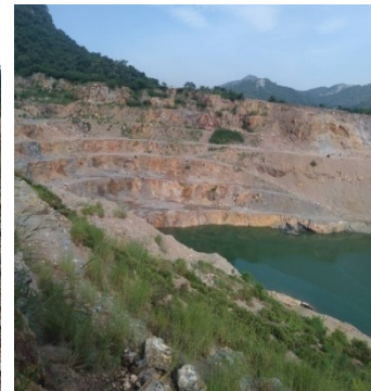
เว้นภูเขาด้านทิศเหนือ ปรับปรุงเป็นชั้นบันไดและปลูกพืช การเจาะรูเตรียมการระเบิดหินและเปิดสัญญาณตามชั้นบันได
