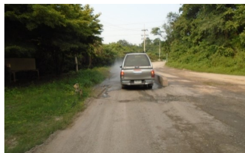
ป้ายแจ้งเตือนให้รถบรรทุกทุกคันปิดคลุมให้มิดชิดก่อนออกสู่ภายนอกโครงการและบ่อฉีดล้างล้อรถก่อนออกสู่ ถนนลาดยาง
